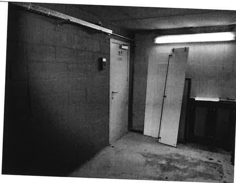
Foto 18 : niet toegankelijke liftmachinekamer in ondergrondse garage -3
