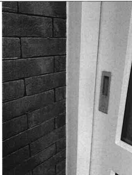
Foto 2 : dichtingsvoegen in silicone
